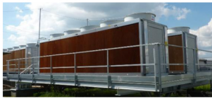
ビル用マルチエアコン室外機 連結式
